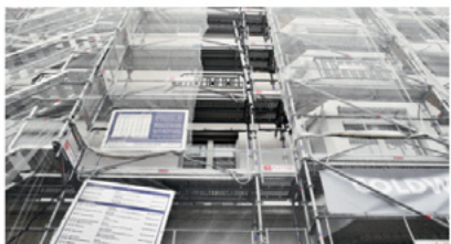
« Depuis octobre 2022, les professionnels peuvent officiellement – sous certaines conditions – démonter le garde-corps intérieur des échafaudages de pied une fois les panneaux d'isolant rigides fixés sur la façade d'un chantier d'isolation thermique par l'extérieur ».
