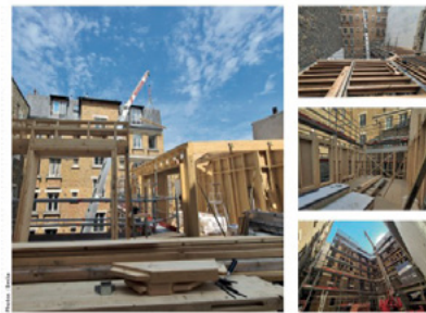
SURÉLEVATION EN OSSATURE BOIS DU PETIT MUSC À PARIS
